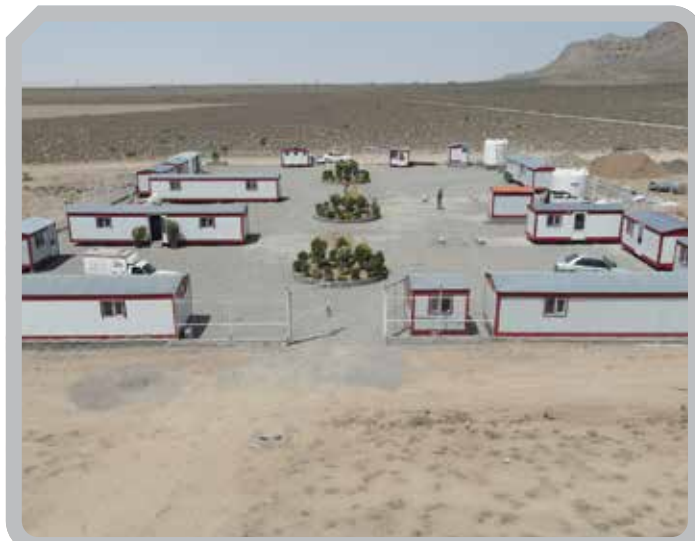
■ تجهیز کارگاه و آغاز عملیات اجرایی پروژه احداث کارخانه کنسانتره
