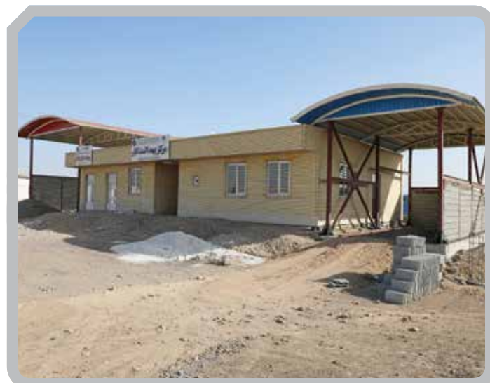
■ تکمیل عملیات ساخت و ساز ساختمان مرکز بهداشت کار و آتش نشانی معدن ۵ گل گهر
